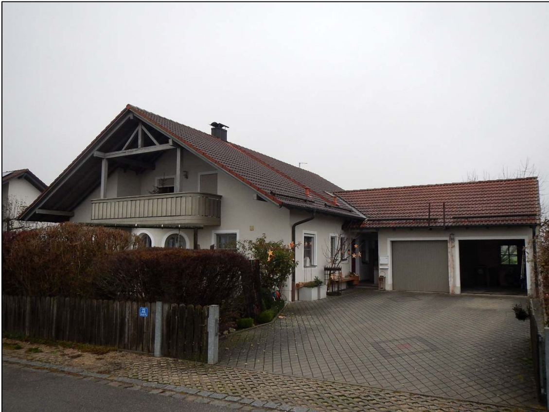
Abbildung 6: Wohnhaus "Altenzeller Weg 21"
