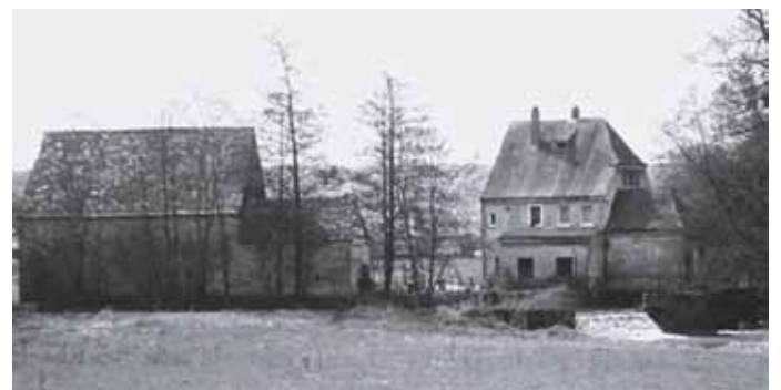
Die Utmühle mit den Nebengebäuden
