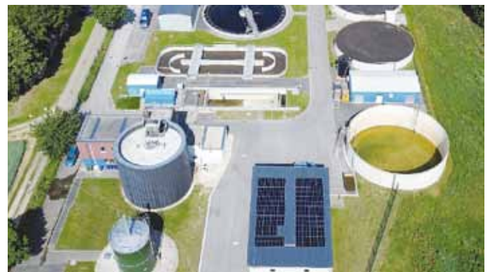
Blockheizkraftwerk II und Photovoltaikanlage
