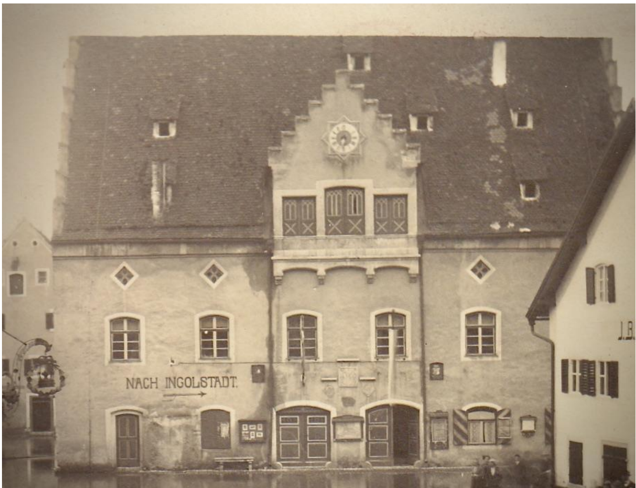
Das heutige Haus des Gastes mit dem übergroßen Dachgeschoss (1939)
