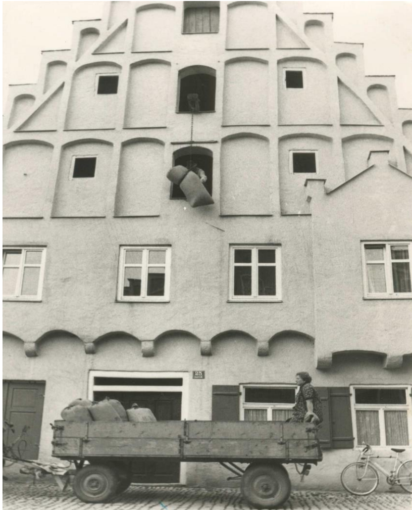
Der Kaiserbeck in der Hauptstraße; mit einem Aufzug wurden die Säcke in das Dachgeschoss gezogen.
