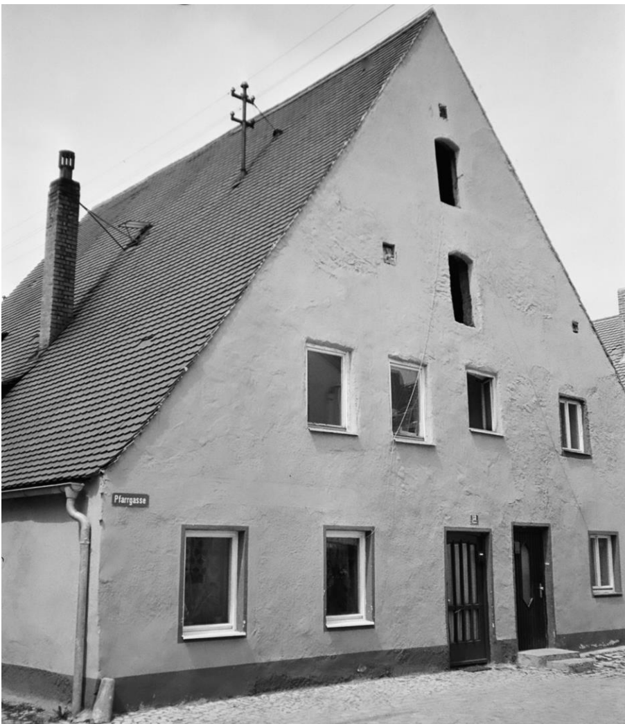
Das Gebäude der Spitalstiftung in der heutigen Pfarrgasse
