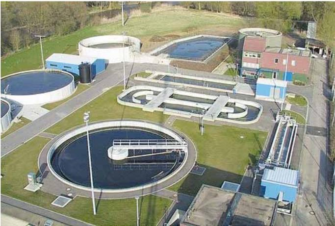
Die Kläranlage verbraucht durch die Maschinen, Kompressoren, Pumpen ca. 1200 kWh Strom am Tag. Durch Vergasung des Klärschlammes im Faulturm entsteht Methangas. Dieses Methangas wird vom BHKW benötigt um elektrische um thermische Leistung zu erzeugen.
