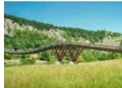
Abgeleitet vom uralten Prinzip der freihängenden Seilbrücke überspannt eine der längsten Holzbrücken Europas den Main-Donau-Kanal auf Höhe des Essinger Ortsteils Weihermühle. Die ungewöhnliche Konstruktion ist fast 200 Meter lang und hält pro Quadratmeter 500 Kilogramm aus. **Gemeinde Essing, Tel. 09447/920093, [www.marktessing.de](http://www.marktessing.de)**
